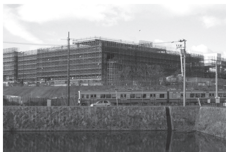
逆池から建築中のビルを臨む
