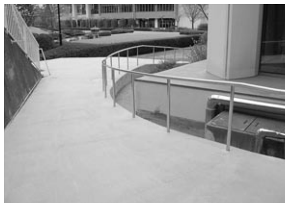
中央棟病院スロープ
